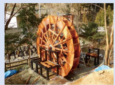
小水力発電のための水車 設置支援(北塩谷区)
