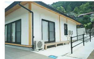
通路に面した縁側
