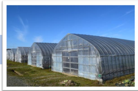
新規施設設置（ビニールハウス）
