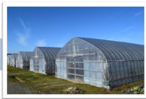
②新規施設設置（ビニールハウス）
