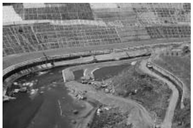
対策工事が始まった白屋地区
