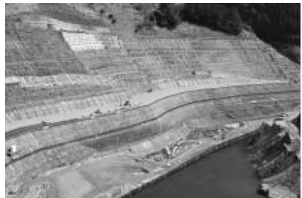
進む白屋地すべり対策工事
