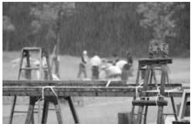
大粒の夕立のなか、機械工具などの撤収作業
