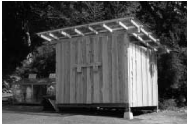
倉庫（上谷区） 製作 大阪市立大学・摂南大学
