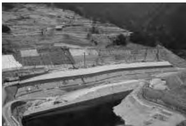
白屋地区地すべり対策工事
