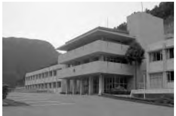
耐震診断を行う川上中学校
