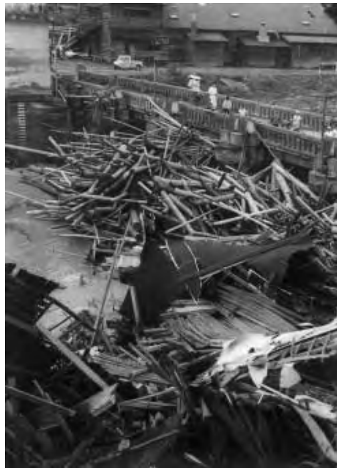
増水が治まってきた材木橋 (吉野町上市)
