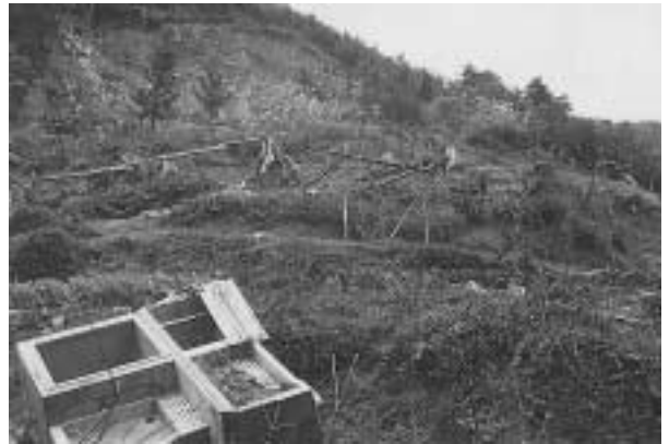
土砂崩れの跡
