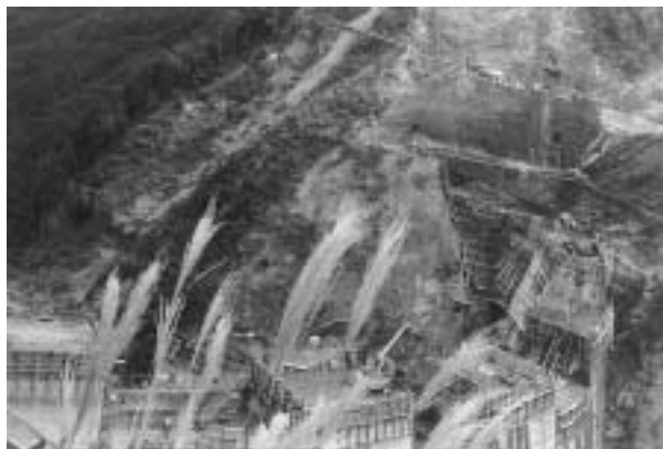
建設が進められた大迫ダム
