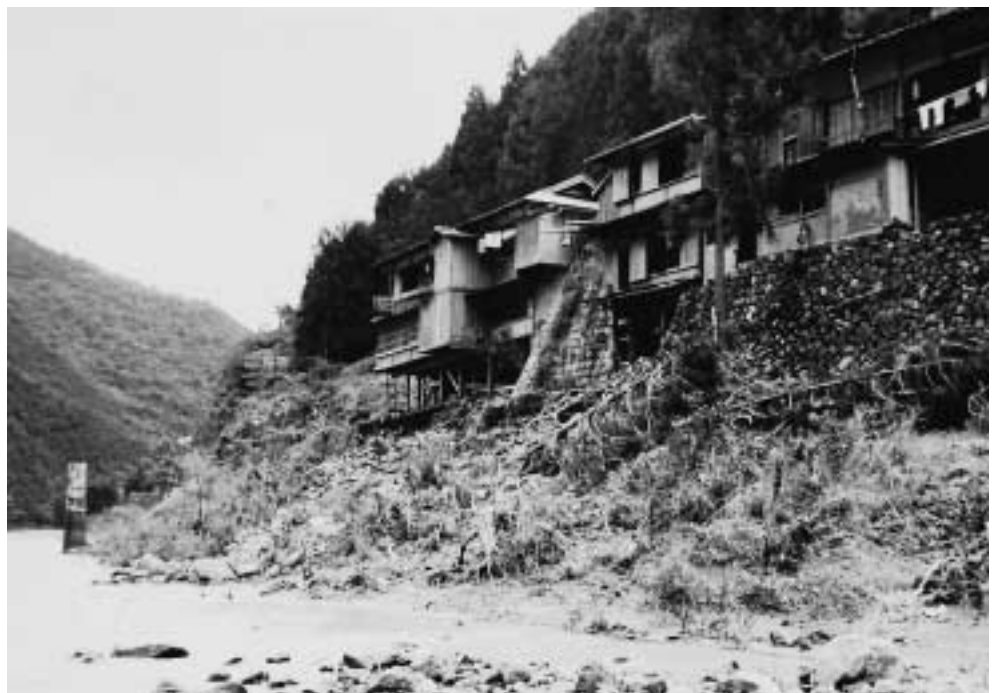
流された高岩橋の橋脚と国道側の様子
