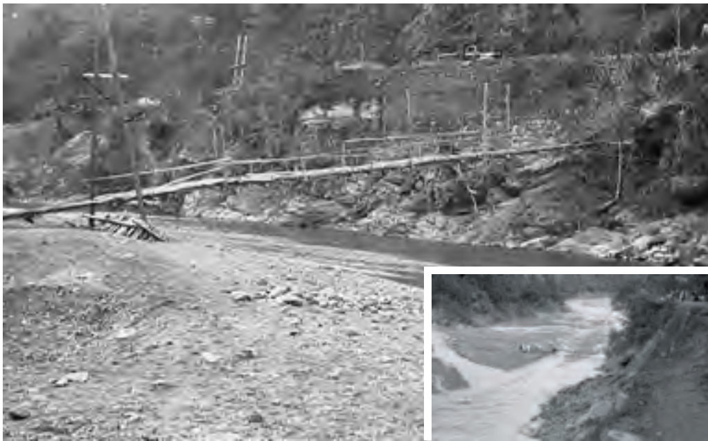
井光と武木が協力して架けた吊り橋（右下が最初の吊り橋）
