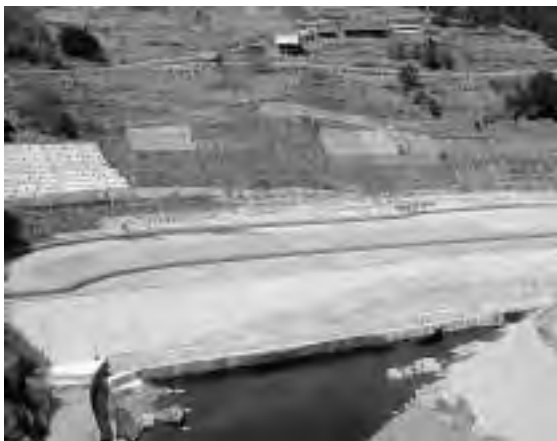
白屋地区地すべり対策工事
