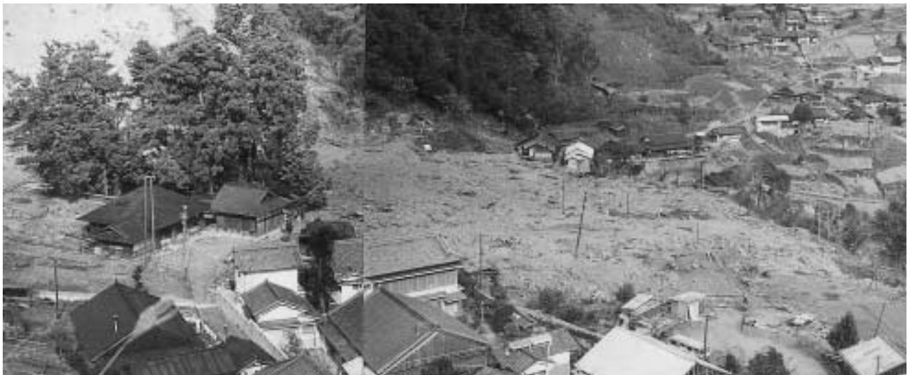
山津波によって土砂で埋め尽くされた家屋
