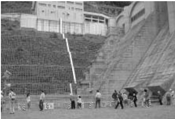
ダム直下から見上げる堤体
