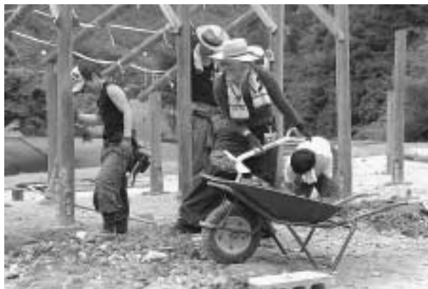
パーゴラの補修（西河）
