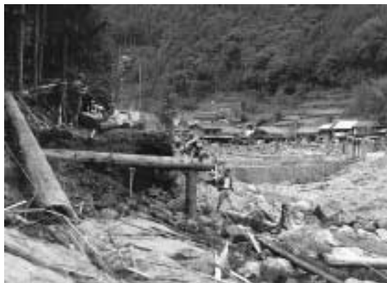
大滝の栈道工事
