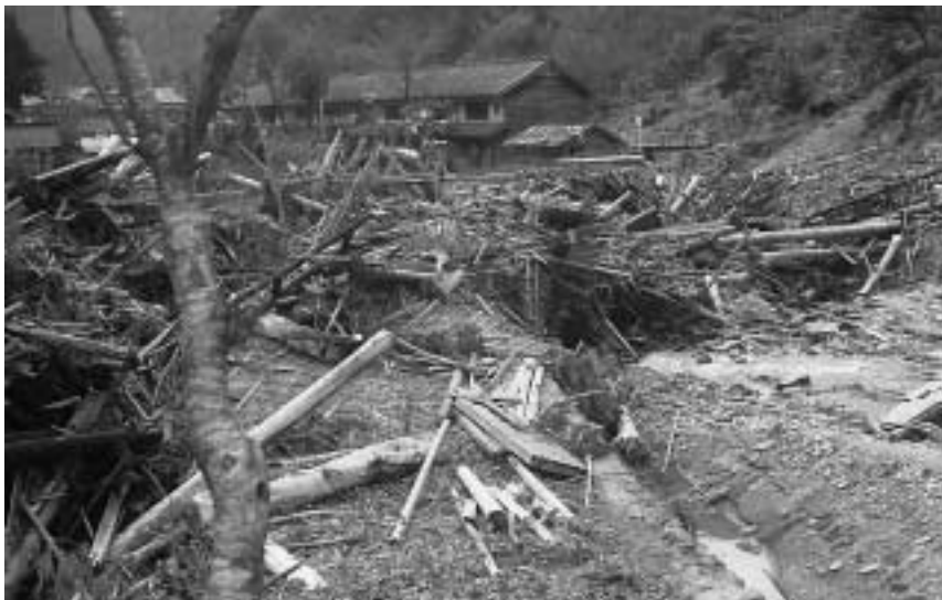
隧道に引っかけりダムと化した音無川
