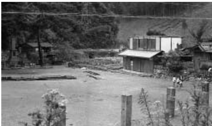
屋根を飛ばされた家屋（旧第1小学校周辺）
