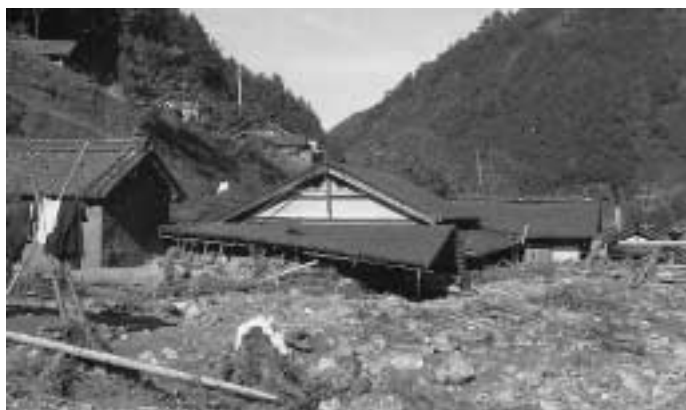
堆積した土砂に埋もれた家屋
