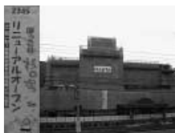
工事が着実に進んでいます！
