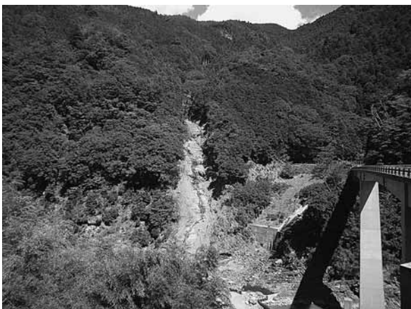
井戸の土砂崩れ
