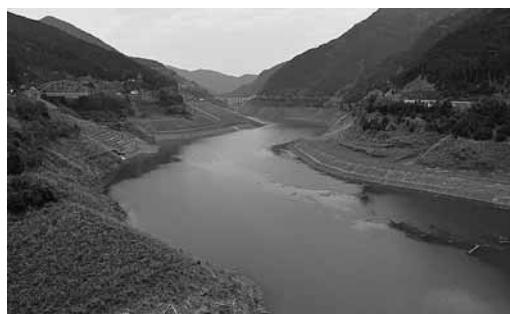
試験湛水へ水位をあげる大滝ダム(11月30日撮影)
