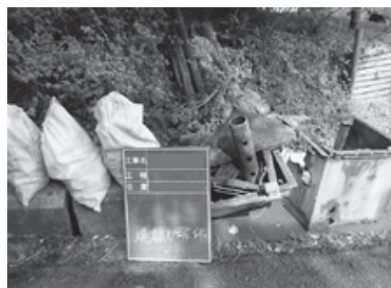
解体された小型焼却炉
