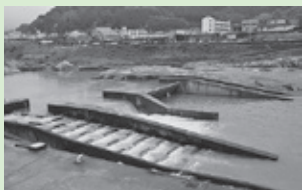
下淵頭首工（大淀町）
