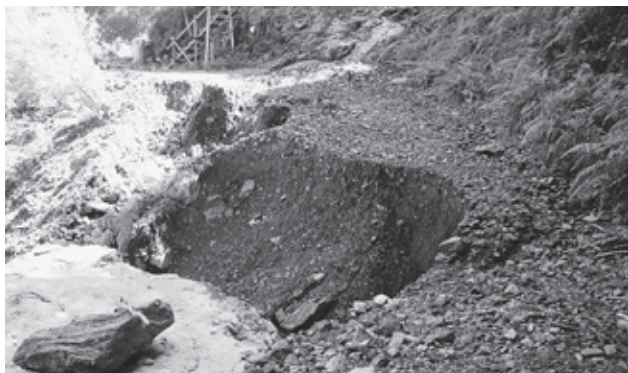
崩壊や土砂崩れで大変な状態になった源流学の森へ続く作業用林道
