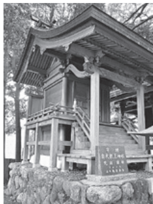
鐘つき堂の一部修繕
