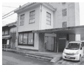
吉野町上市地区に事務所を開設
