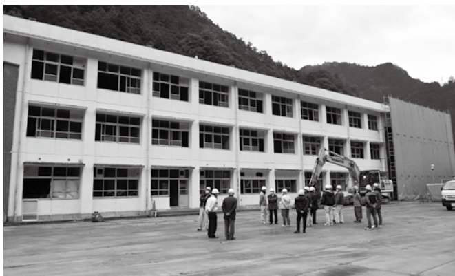
小学校解体現場
