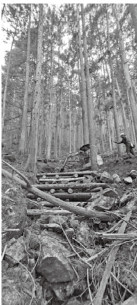
作業道の施工
