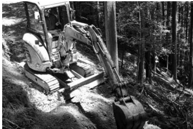
地域おこし協力隊による重機を活用した林業作業道開設
