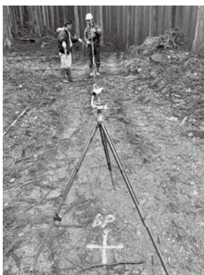
作業道の測量
