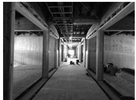
間仕切り壁が立ち上がってきました
