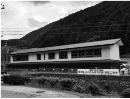
外部足場が撤去された保育園棟
