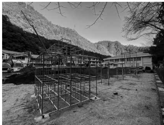
移設中の遊具
