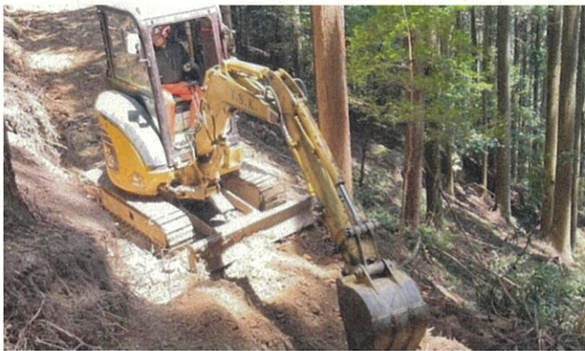
重機で作業道を開設
